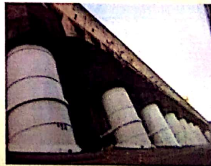
Dutos da Hidroelétrica de Itaipu
